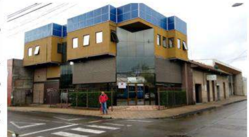
1. Vía de Escape
